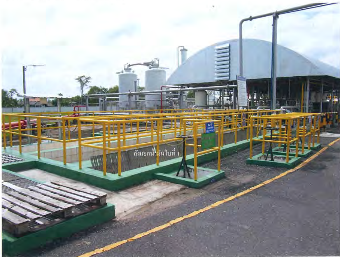
รูปถ่ายที่ 1 ถังแยกน้ำมันใบที่ 1 แบบ CPI ที่อยู่ภายในคั่งน้ำมันเซลล์บ้านคอน สุราษฎร์ธานี
